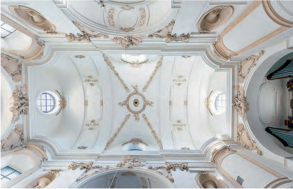
Abb. 4: Blick in das Gewölbe, nach der Restaurierung 2022
