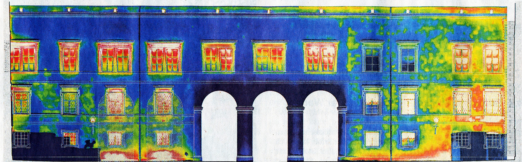
Ein thermografisches Bild des Wallstrakts der Salzburger Residenz.
